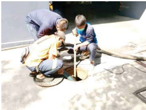
สูบน้ำก่อนระบบบำบัดน้ำเสีย
